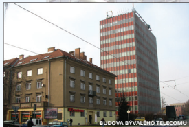
BUDOVA BÝVALÉHO TELECOMU
