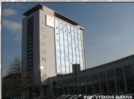
BVV - VÝŠKOVÁ BUDOVA
