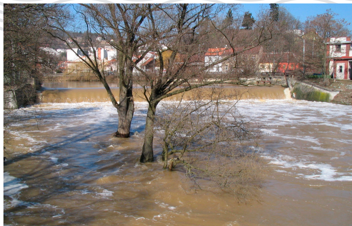
rok 2005, Komín - jez na řece Svatce ←
