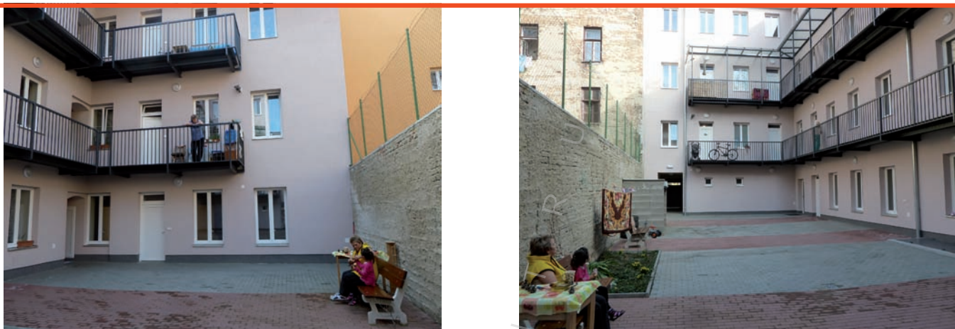
bytový dům FRANCOUZSKÁ 68, dokončeno v březnu 2012
