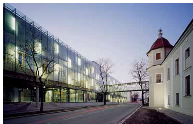
▲ Informatici za zdi kláštera. Chátrající areál bývalého kláštera přeměnilo Vysoké učení technické na objekty pro Fakultu informačních technologií. V historických budovách vznikly výukové prostory, pracoviště ústavů a děkanát. Laboratoře, technické místnosti, ubytovací a stravovací služby a společensko-kulturní zázemí jsou umístěny do nově vybudovaného komplexu. Obě části areálu jsou propojeny pěší lávkou přes ulici Božetěchovu. Foto: FIT VUT v Brně
