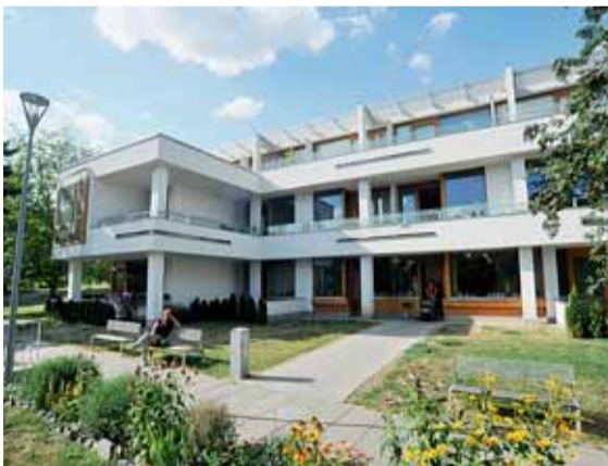
▲ Misto dětí senioři. Přestavbou bývalé školky ze 70. let na Vavřínecké ulici v Komině vznikl bytový dům s pečovatelskou službou se 17 byty. Budova, kterou v posledních letech jen částečně využívala knihovna Jiřího Mahena, byla v havarijním stavu. Při rekonstrukci byl kladen důraz na potřeby seniorů – možnost komunikace s ostatními obyvateli a vizuální kontakt s okolím. V přízemí vznikl také nebytový prostor pro pobočku zmíněné knihovny. Foto: Z. Kolařík
