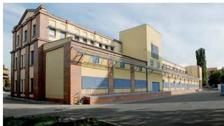
▲ Úložiště pro archiválie. Budova na Přední v Černovicích sloužící původně k transformaci elektrického proudu z oslavanské elektrárny prošla na přelomu let 2001 a 2002 komplexní rekonstrukcí a dostavbou a dnes slouží Archivu města Brna. V přízemí objektu jsou sklady, dílny a technické a sociální zázemí. V prvním patře se pak kromě depozitářů nachází i knihařská a restaurátorská dílna a badatelna s půjčovnou pro veřejnost. Foto: M. Schmerková
