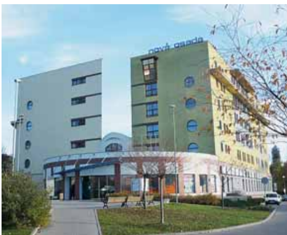
▲ Sídlo obchodníků a úředníků. Soubor budov na Staré osadě známý jako Aeskulap zůstal po privatizaci v 90. letech nedostavěný a vystřídal tři desítky vlastníků. Za peníze veřejné i soukromé byl objekt zrekonstruován a od roku 2005 centrum Nová Osada slouží obchodu, administrativě a službám. Mimo jiné tu sídlí Úřad městské části Brno-Židenice a pobočka Městské správy sociálního zabezpečení. Foto: Z. Kolařík
