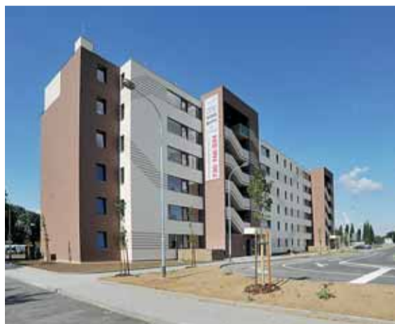
▲ Zelené město Slatina. Areál kasáren při ulici Řípské byl vybudován mezi 1. a 2. světovou válkou jako zázemí vojenského letiště. Aktuálně se zde dokončuje první etapa výstavby bytových domů a začaly práce na etapě druhé. Výsledkem komplexní revitalizace bude asi 450 nových bytů, 800 parkovacích míst, plochy zeleně a sportu, obchodně-administrativní a společenské centrum, sportovní hala, zdravotní středisko s domem pro seniory atd. Foto: Z. Kolařík
