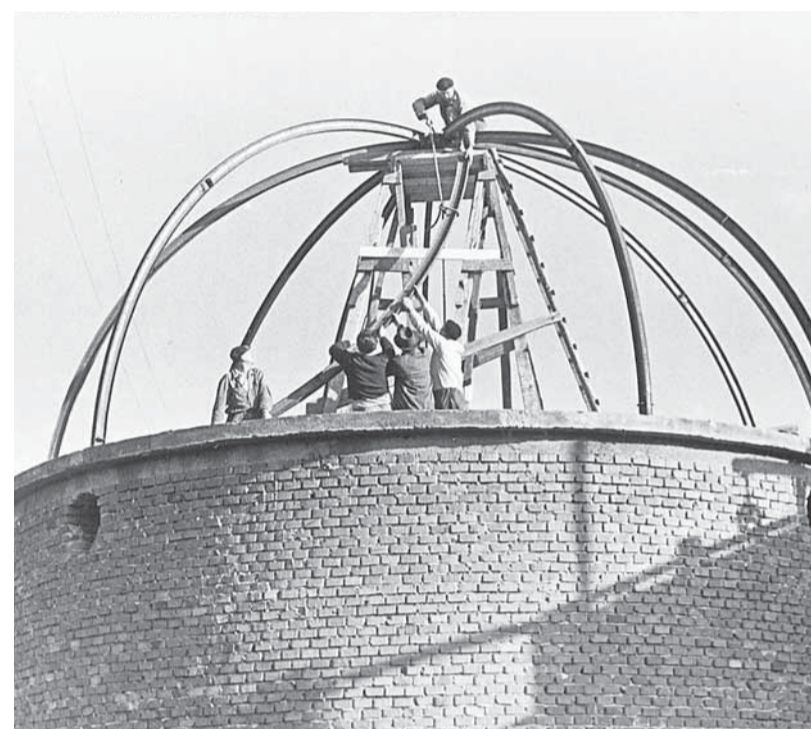
▲ Stavba planetária, 80. léta 20. století. Foto: Hvězdárna a planetarium Brno
