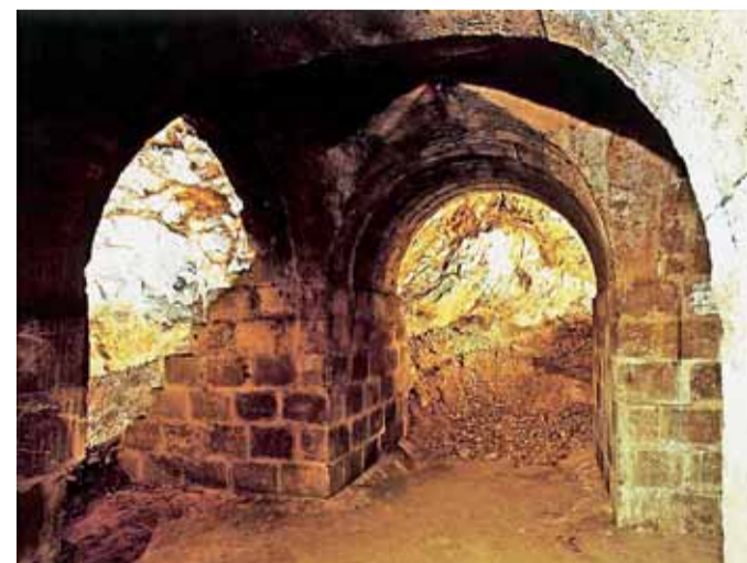
▲ Křížení chodeb v protiletectkém krytu vybudovaném německou armádou na sklonku 2. světové války v masivu Kraví hory. Dnes se do něj vstupuje z ulice Úvoz. Foto: Baran-Francán
