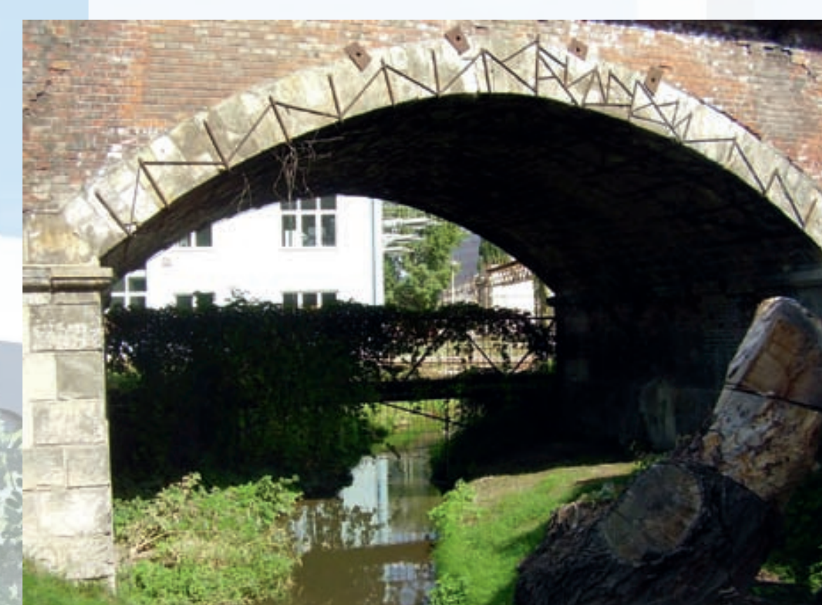
Brno – koryto Svitavského náhonu protéká pod obloukem železničního viaduktu
