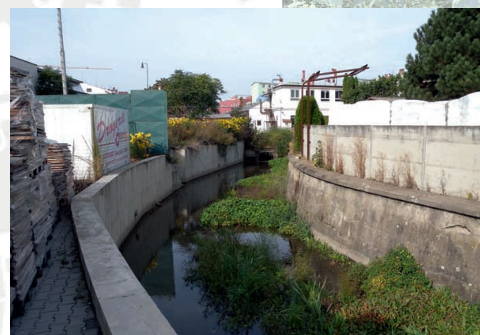
1 OPEVNĚNÉ KORYTO POD ULICÍ TKALCOVSKÁ V dnových nánosoch vyrůstá litorální vegetace, úsek je bohatě zarybněný.
