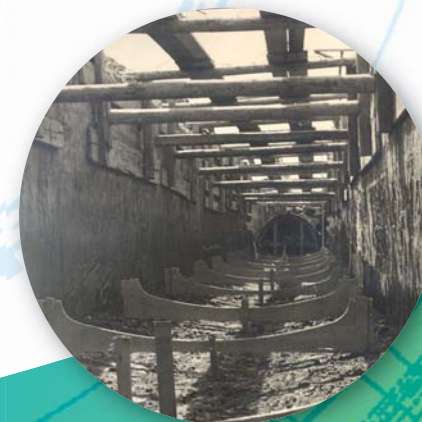
Kyneta před betonováním
