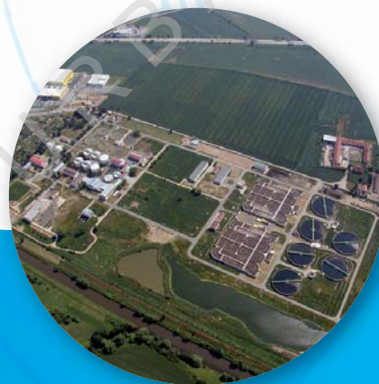
Čistírna odpadních vod v Modřicích
