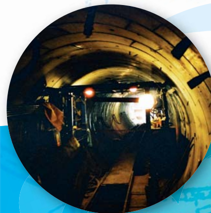
Výstavba kmenové stoky →
