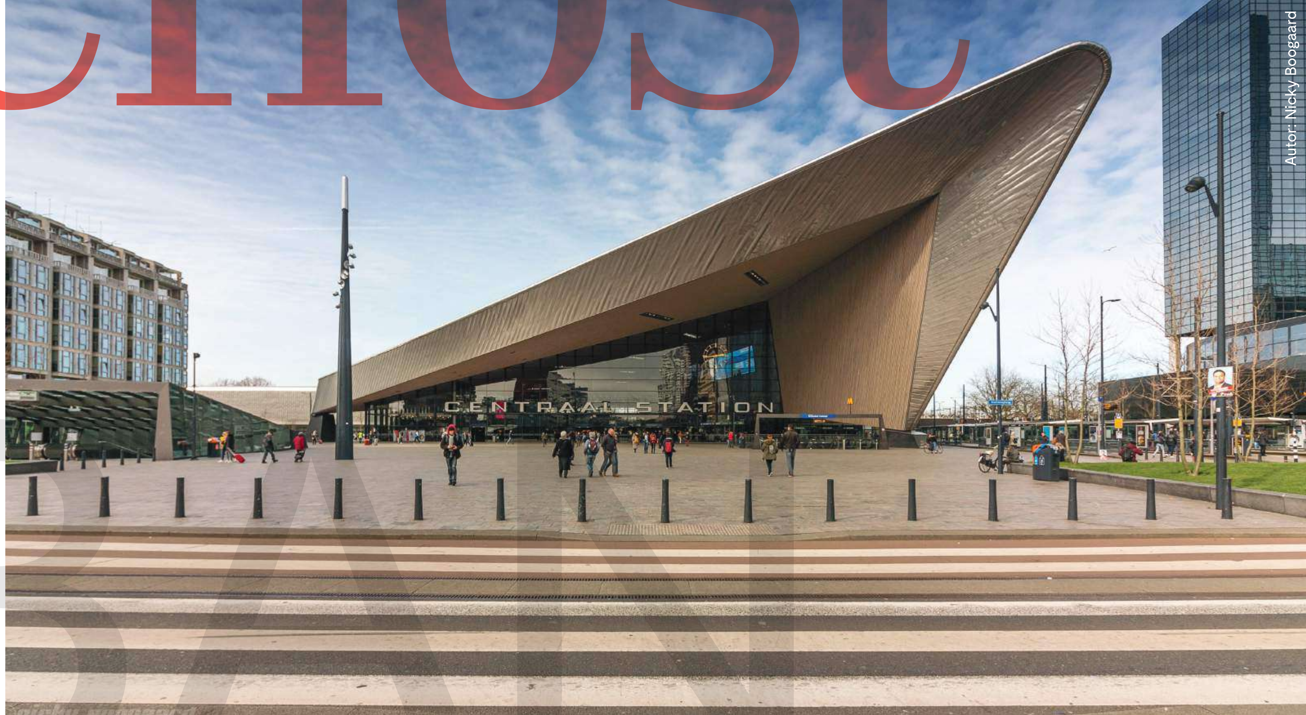
Rotterdam Centraal Station, Nizozemsko. Benthem Crouwel a MVSA Architects. Realizace 2007-14
