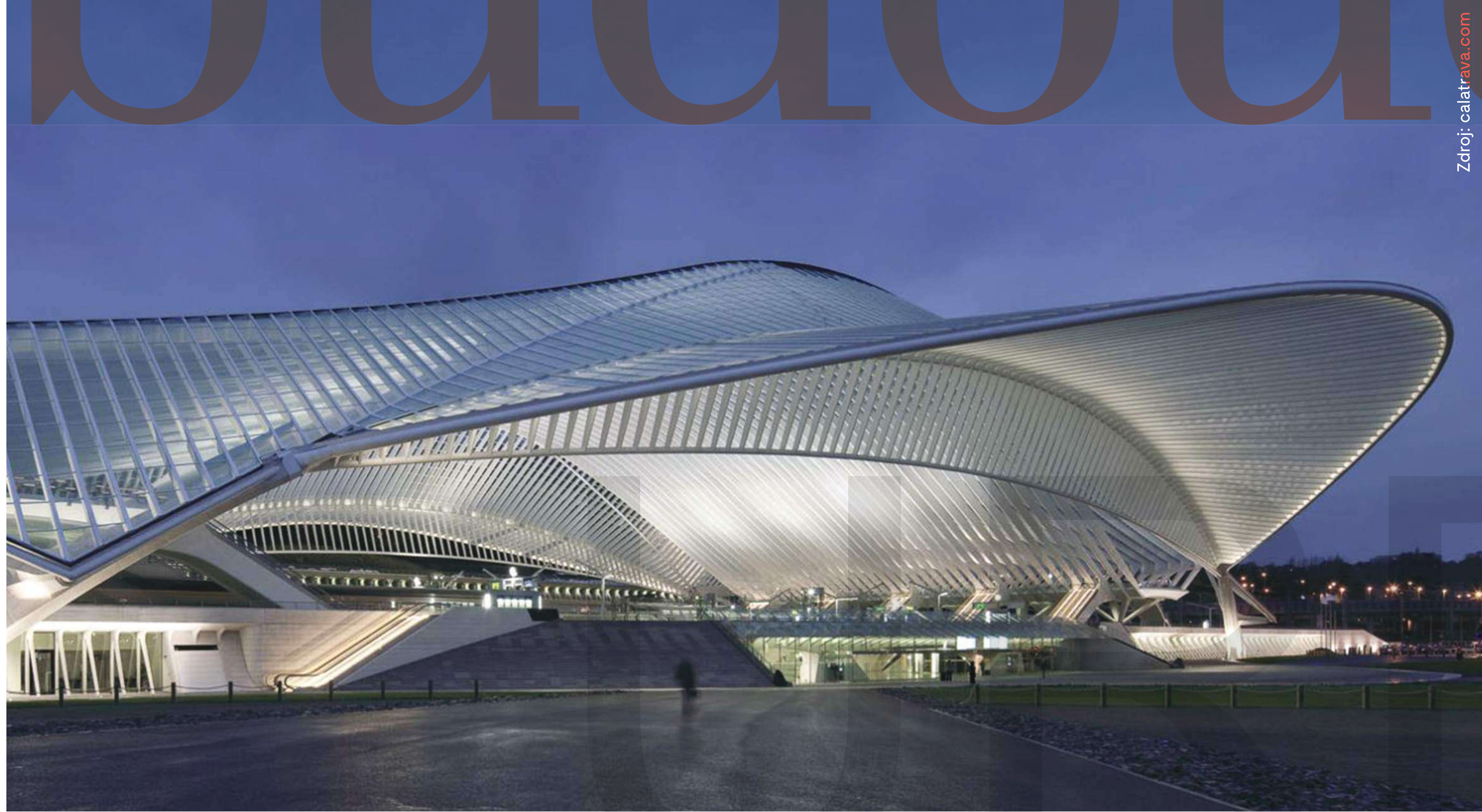
Liège-Guillemins, Luty, Belgie. Autor Santiago Calatrava. Realizace 2000-09
