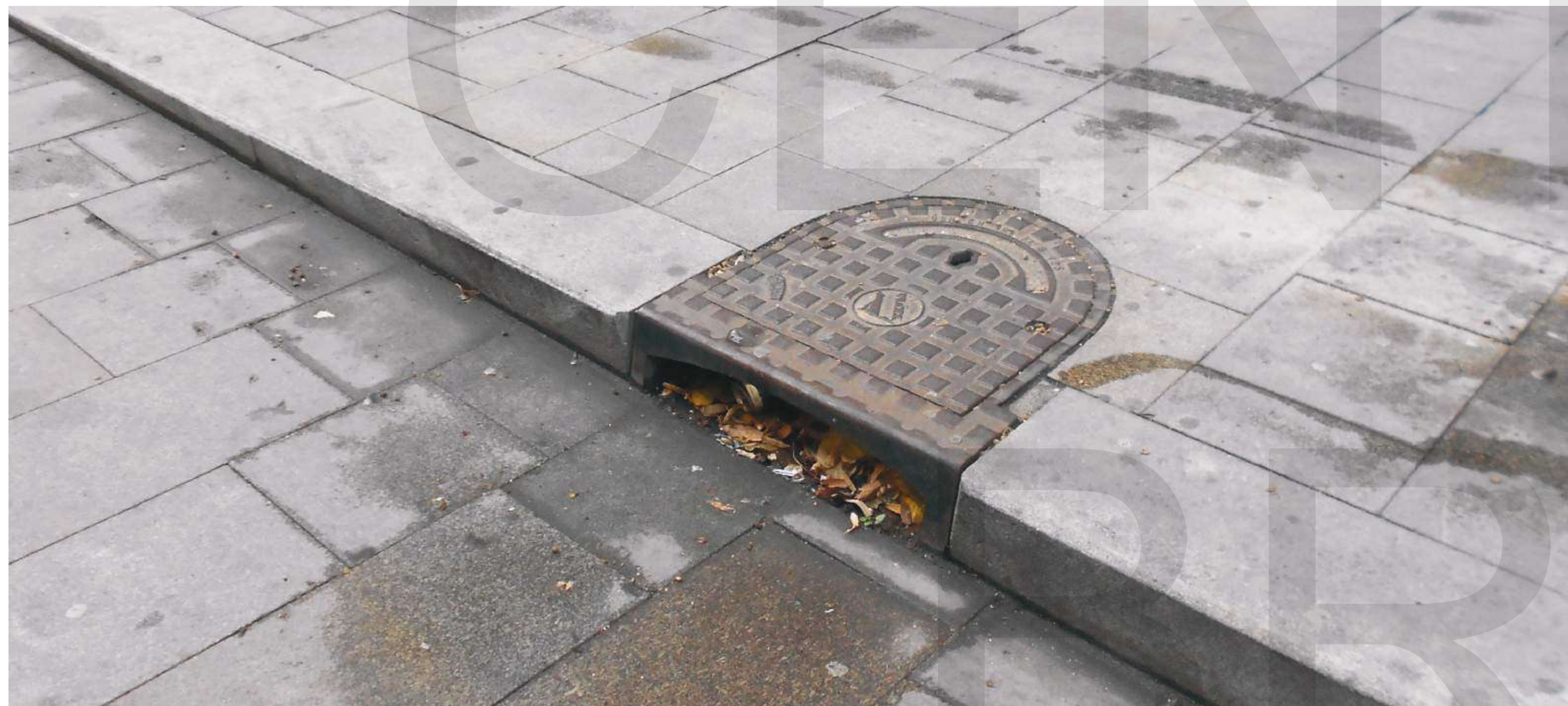
Litínová obrubníková vpust je nezbytným řešením ve stísněných podmínkách, kde jsou běžně používané mříže vpustí nadměrně namáhané provozem.
