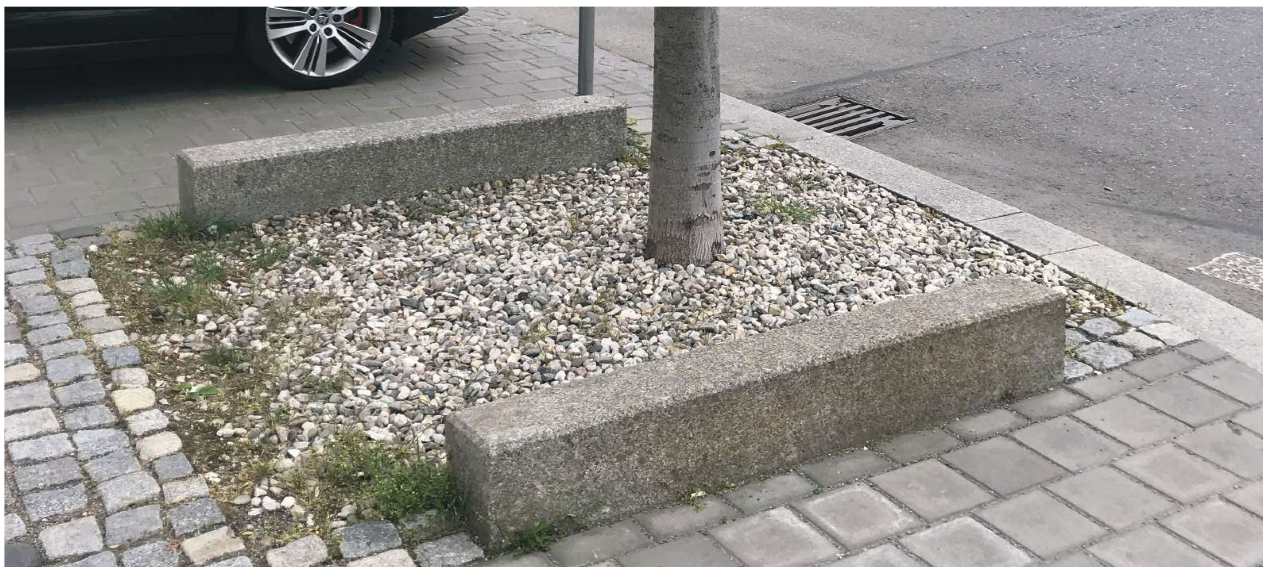
Aby strom prospíval, je potřeba zajistit dostatečný prostor pro jeho růst a ochránit jej proti poškození. Kamenné bloky chrání před parkujícími auty kmen i kořenový prostor.
