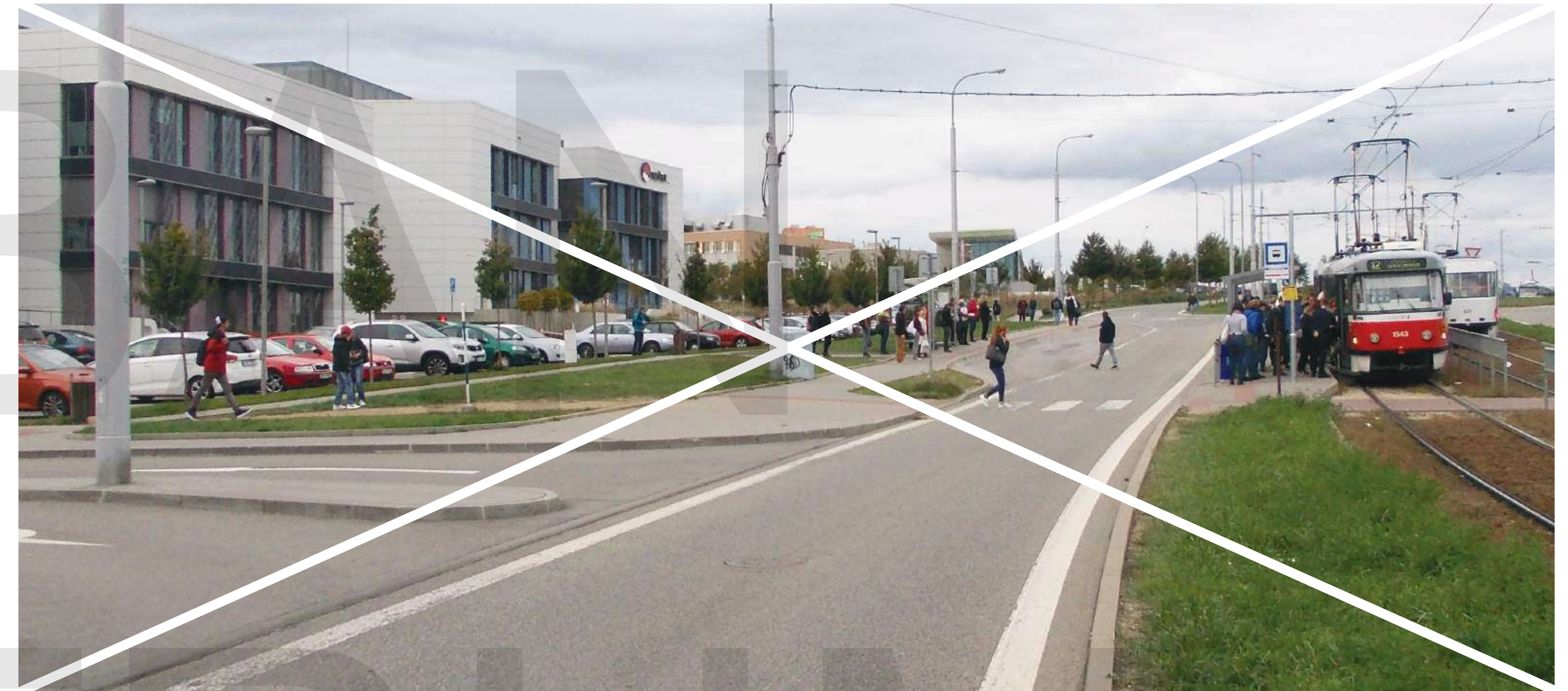
Nadřazení technických sítí nad ostatní prvky vede k tomu, že v zelených pásích jsou namísto stromů osazeny kanalizační šachty a signalizační tyče vedení vodovodu. Takto vzniká periferie, nikoli město.
