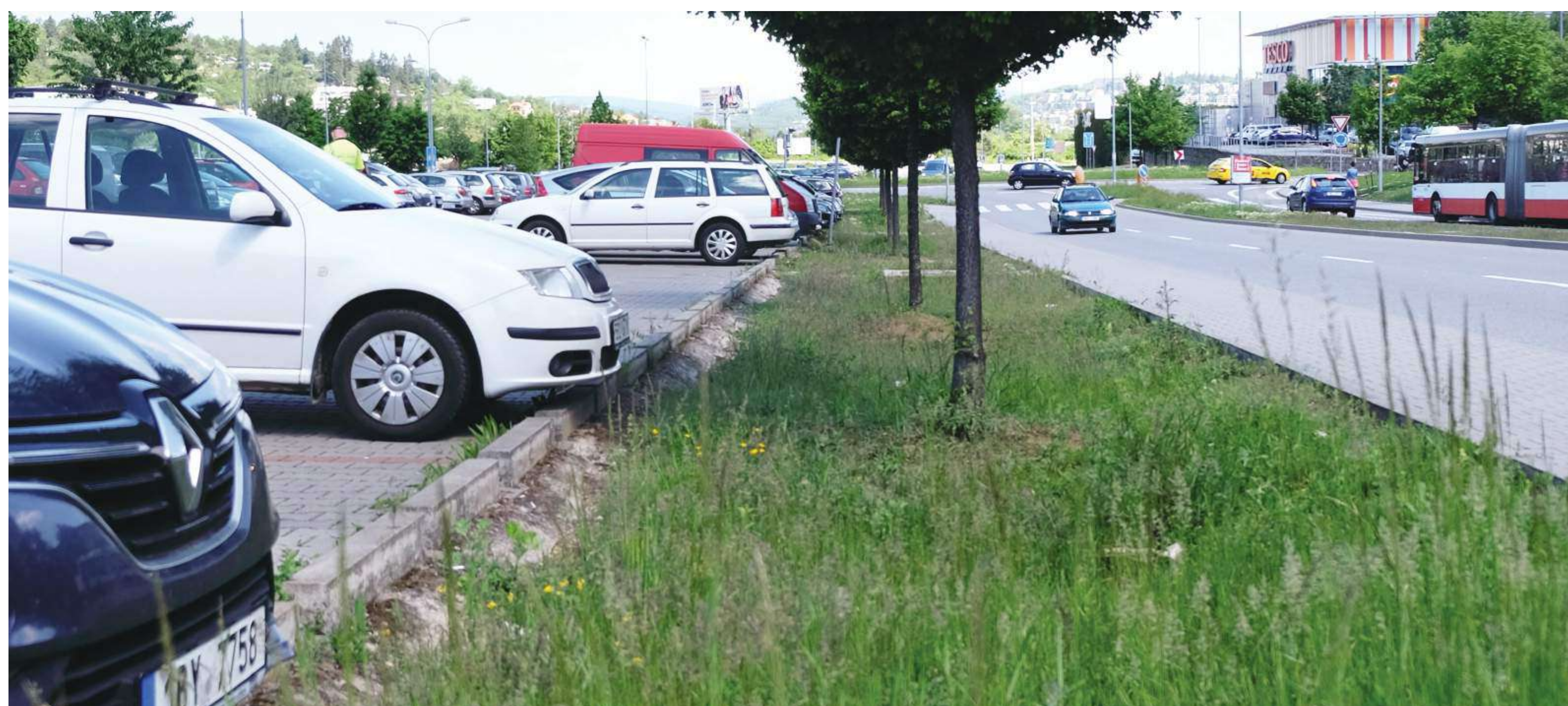
Dostatečně široký průleh, který slouží k odvodnění přilehlého parkoviště. Je možné ho jednoduše udržovat, nepředstavuje zásadní bariéru v pohybu chodců a je vhodný i pro výsadbu stromů.
