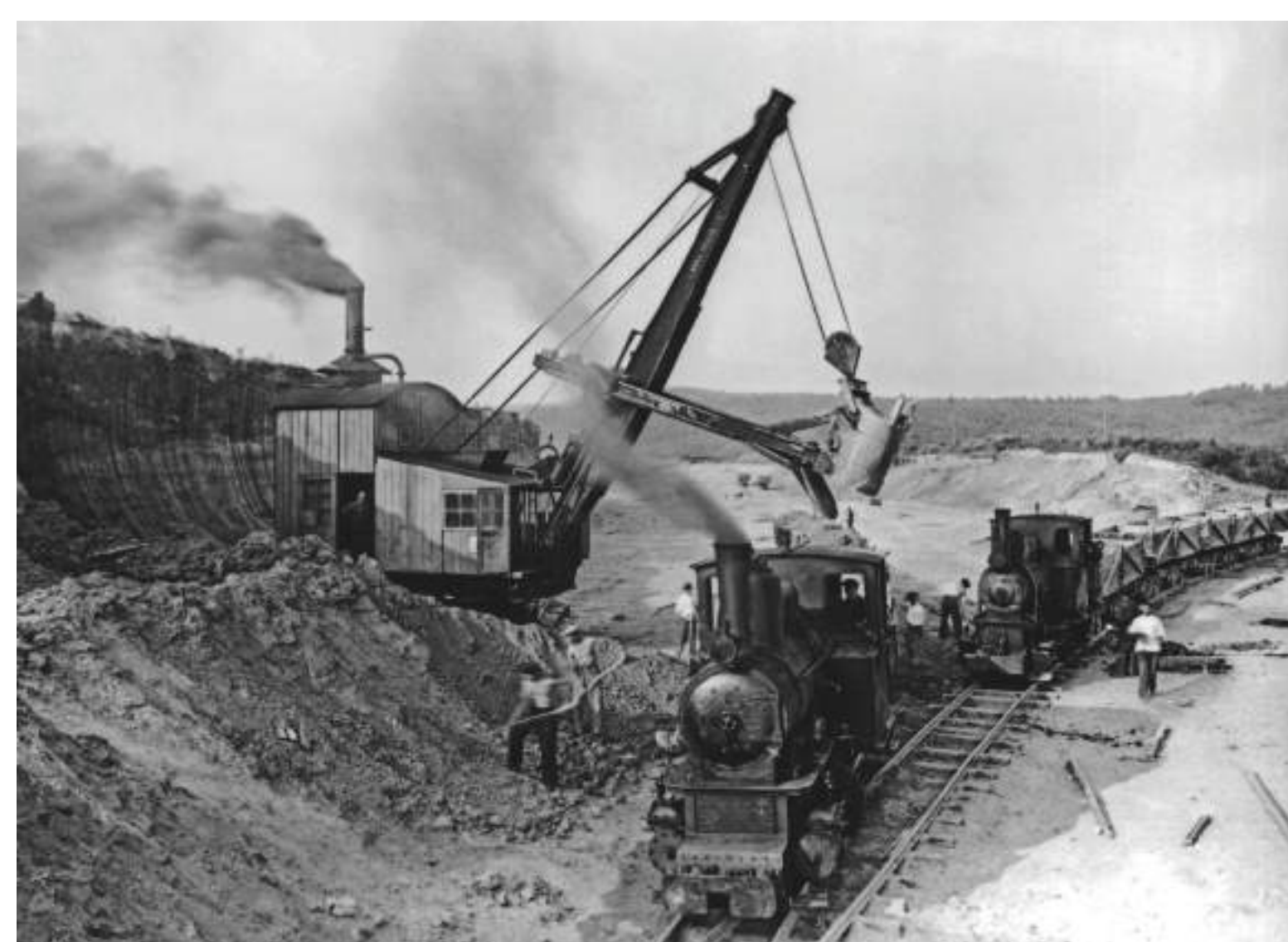
Stavba exteritoriální dálnice Vídeň–Vratislav zdroj: Technické muzeum v Brně
