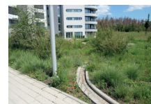
Ulice Netroufalky – srážkové vody jsou do přírody blízkého retenčního objektu svedeny z přilehlých zpevněných ploch
