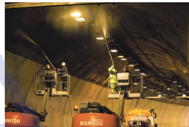
Brněnské tunely vyžadují údržbu, aby však mohla být provedena, je třeba je jednou za čas uzavřít. Foto: Jiří Salík Sláma
