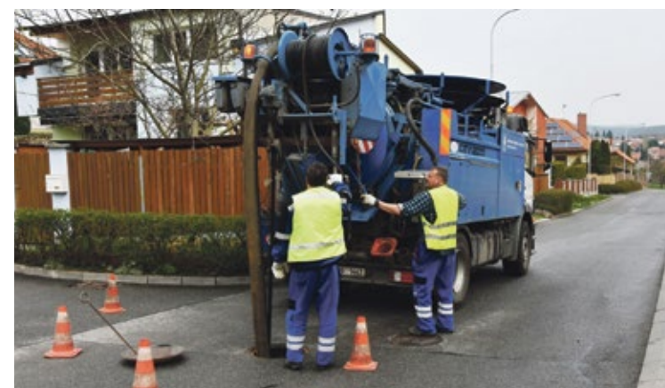
Čištění kanalizace se provádí pomocí techniky i ručně. Foto: Brněnské vodárny a kanalizace
