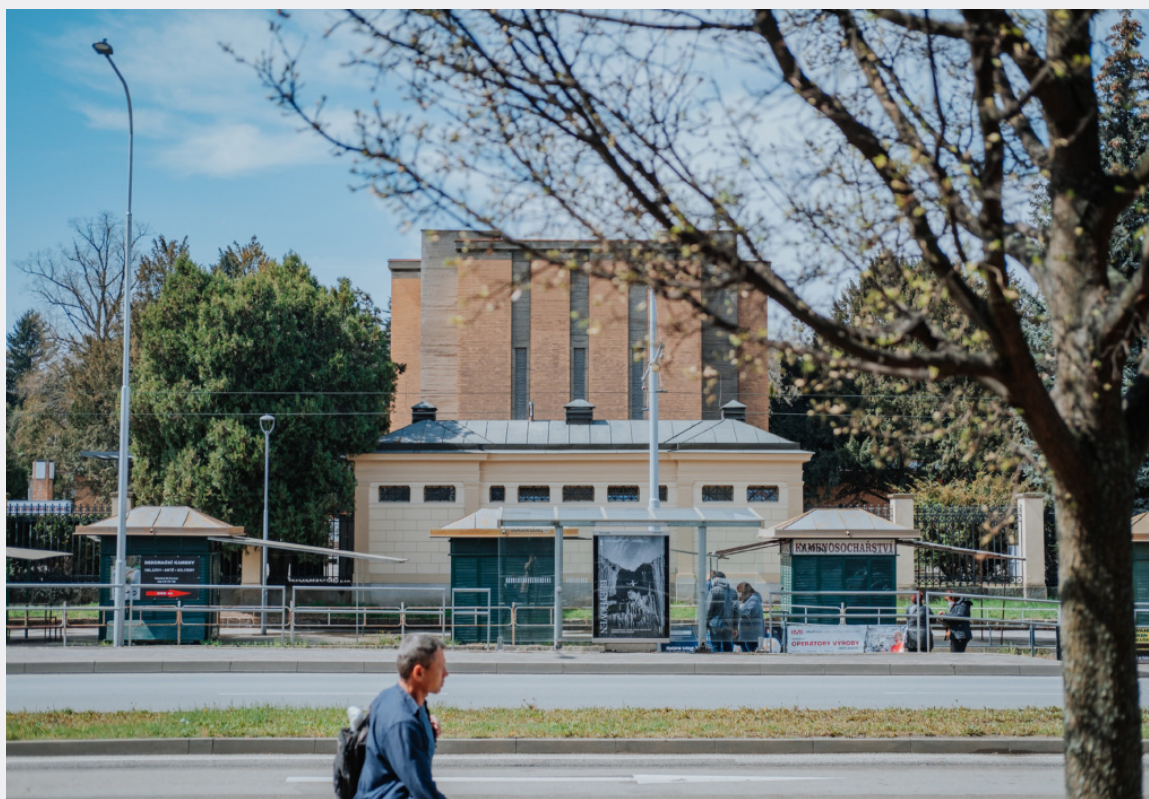
Hlavní vstup z ulice Vídeňská
