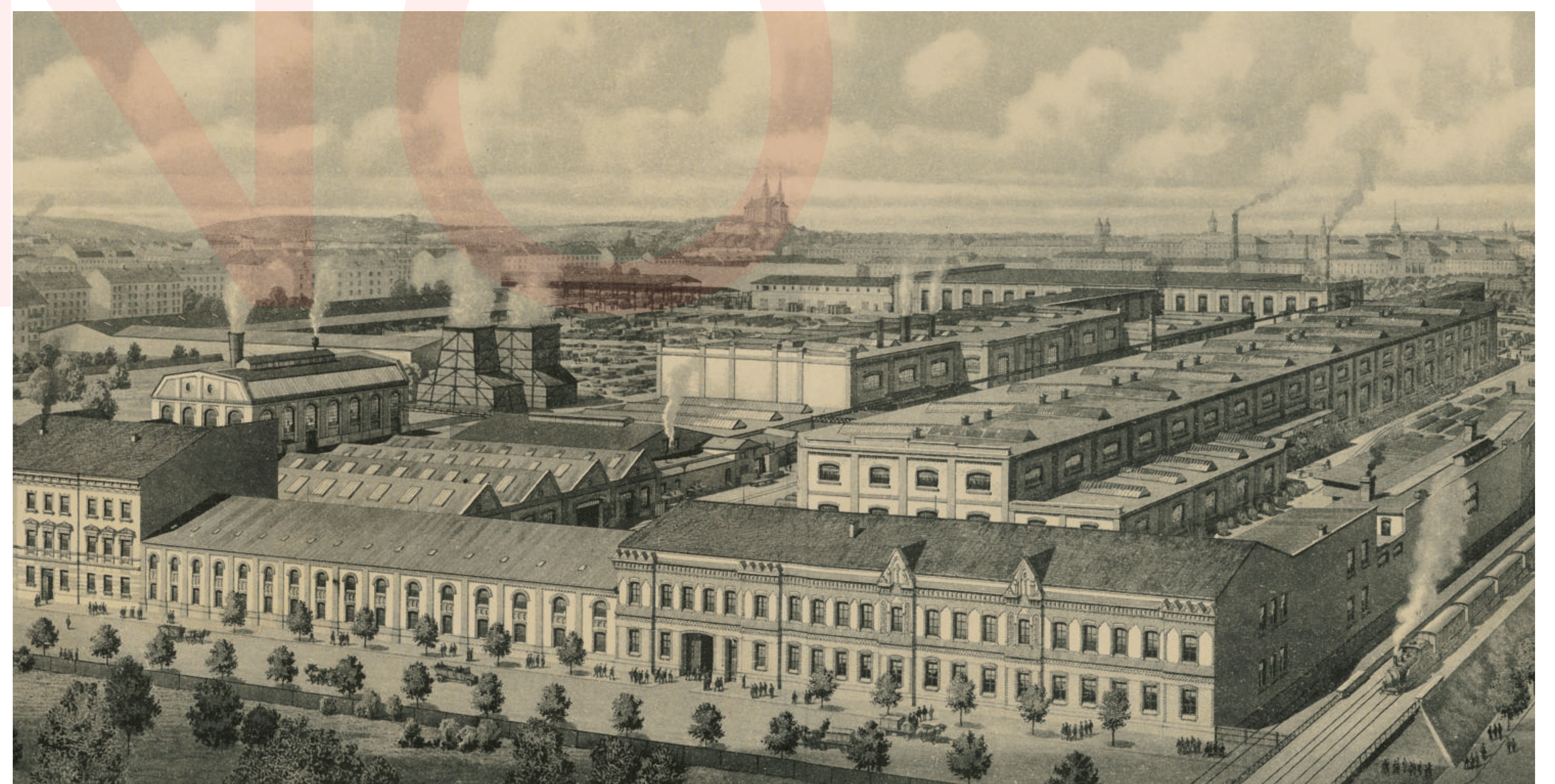
Strojírny Bedřicha Wanniecka
