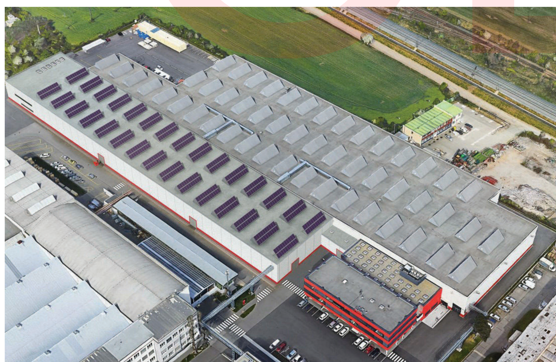
Instalace FVE na střechách budov společnosti ABB
