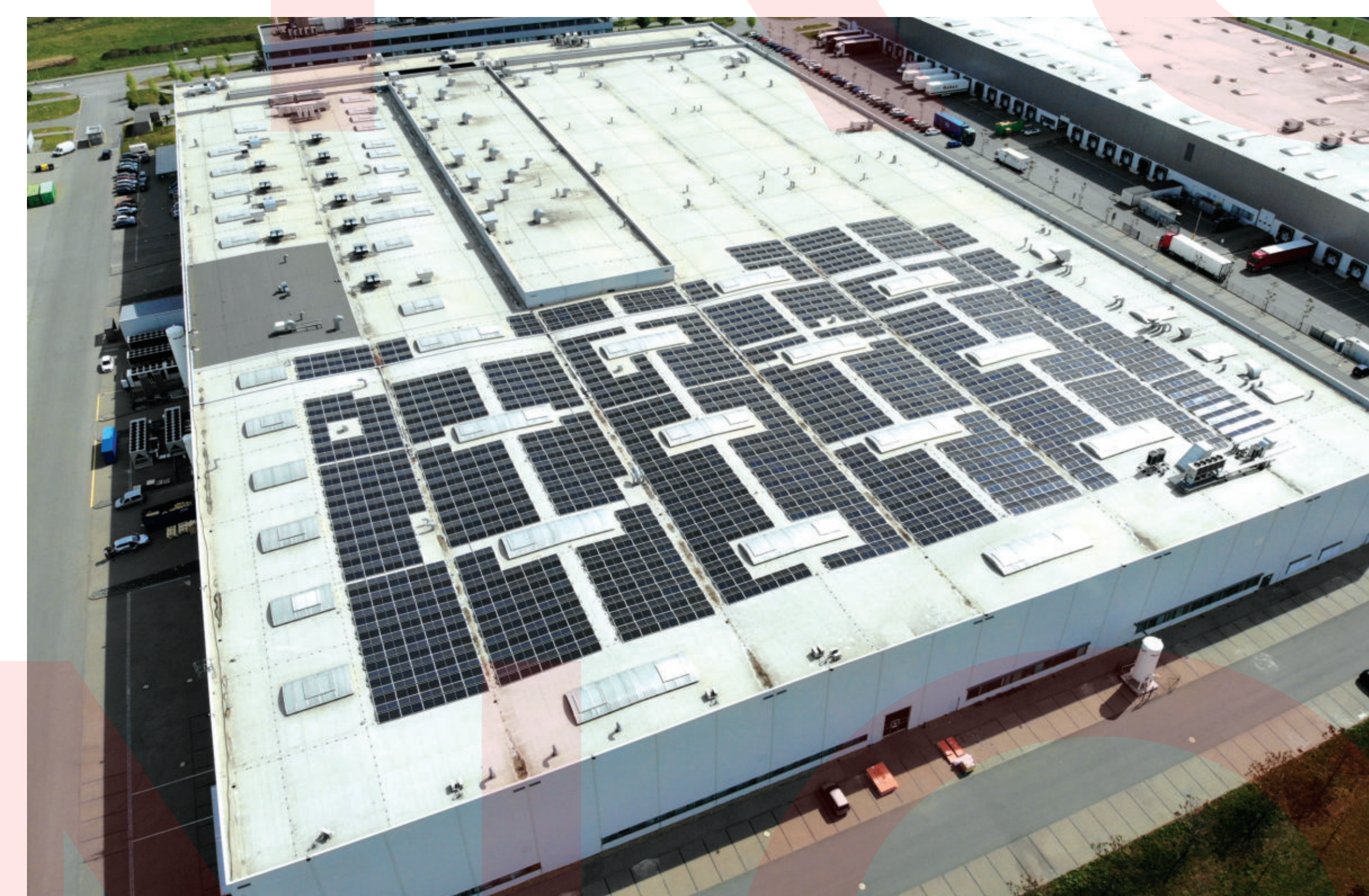
Instalace FVE na střechách budov společnosti Thermofisher
