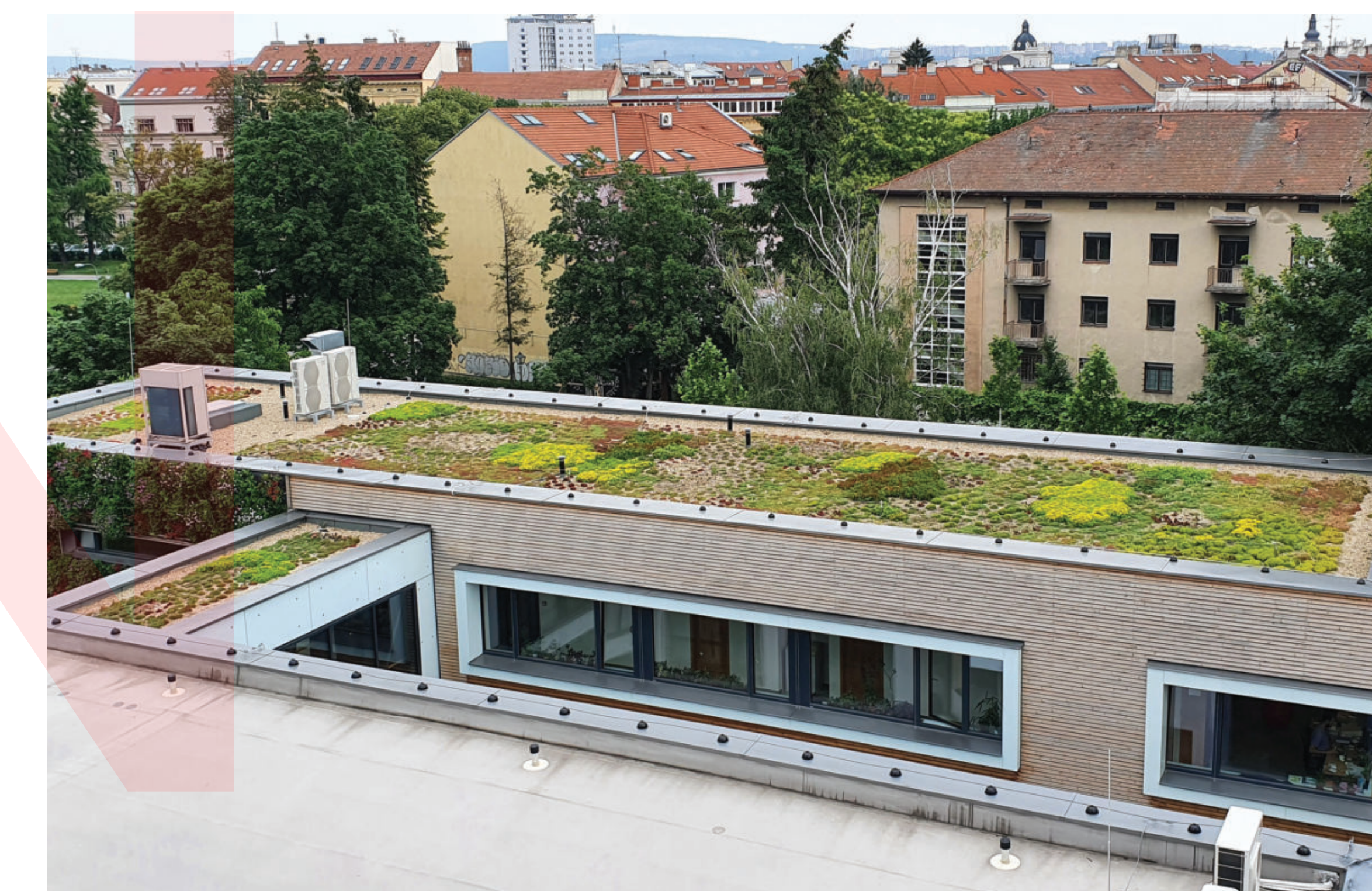
Kancelář veřejného ochránce práv a zelená střecha
