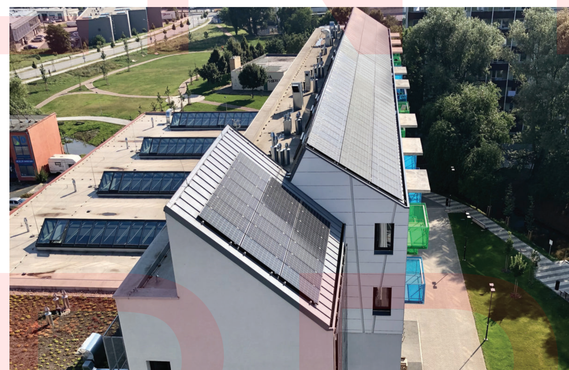
Instalace FVE na střechách budov Areál Svatopetrská
