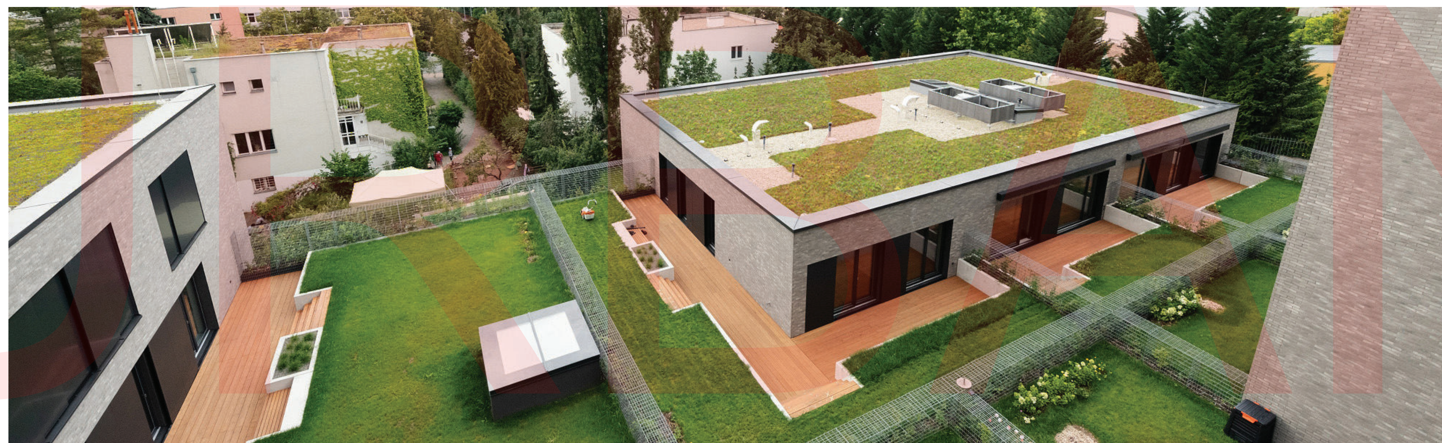
Zelená střecha bytový dům Neumanka
