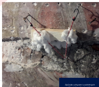
Odstranění přebytečného malby a vyčištění malby 3.
