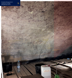
Odstranění přebytečného malby a vyčištění malby 3.
