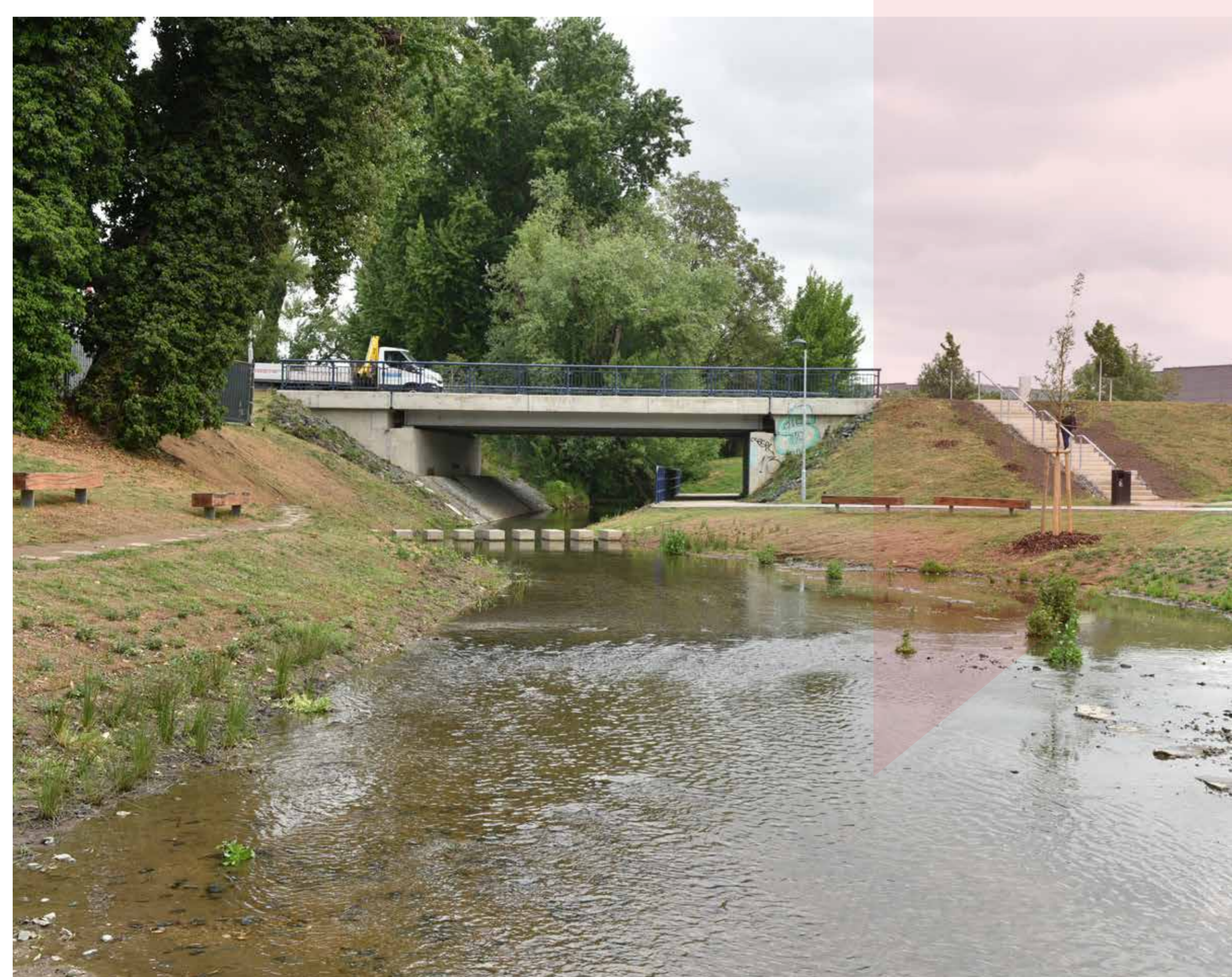
Revitalizace Staré Ponávky – park Komárov
