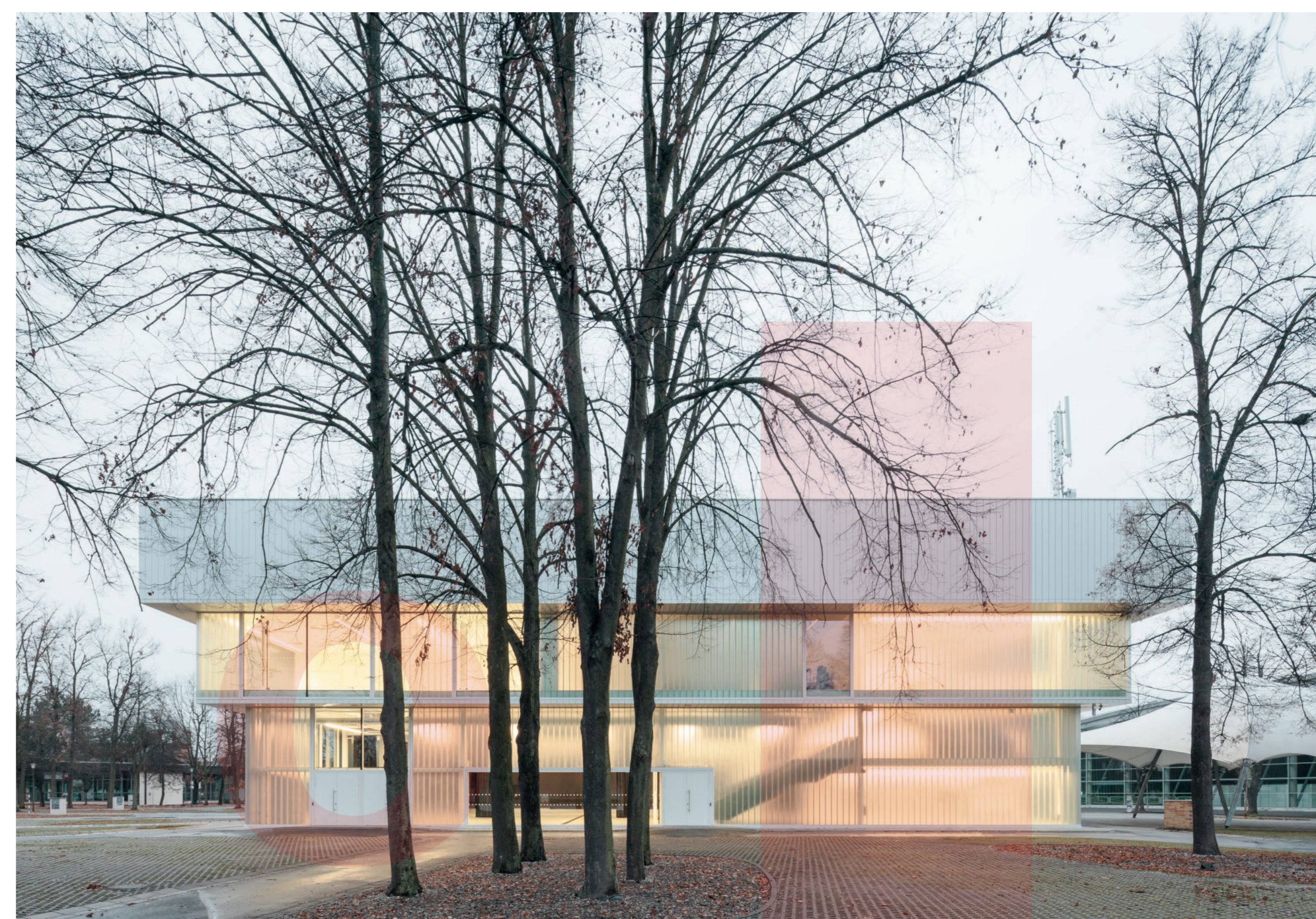
REKONSTRUKCE PAVILONU Z, ČESKÉ BUDĚJOVICE RECONSTRUCTION OF PAVILION Z, ČESKÉ BUDĚJOVICE Photo: Ondřej Bouška
