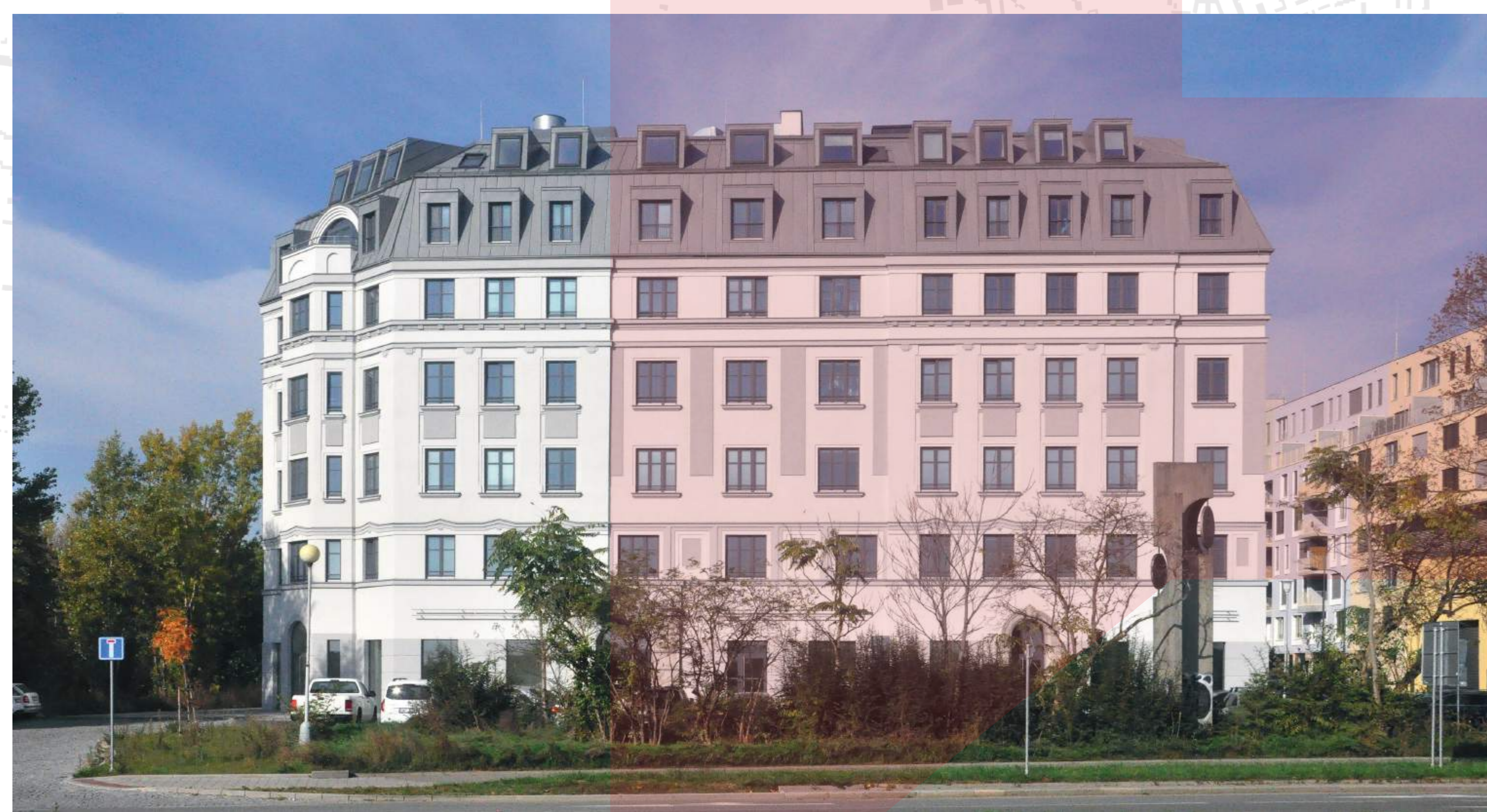
REZIDENCE U VAŇKOVKY, POHLED NA ZACHOVANOU SECESNÍ FASÁDU OD ULICE OPUŠTĚNÁ FOTO: BRNĚNSKÉ KOMUNIKACE
