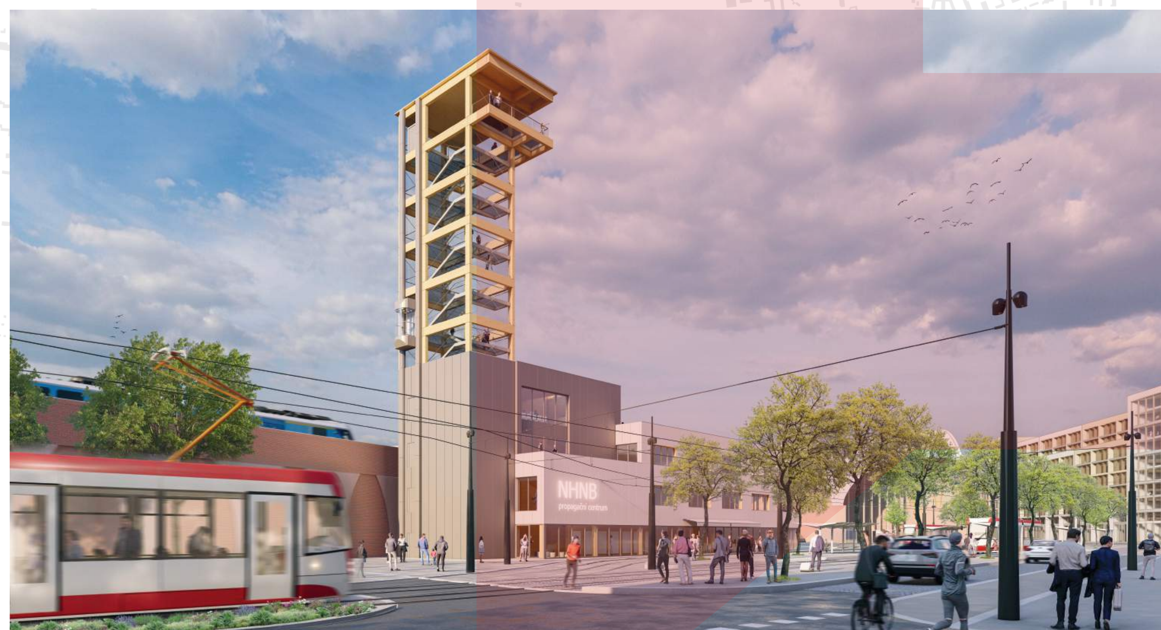
PROPAGAČNÍ CENTRUM S KONSTRUKCÍ Z CLT PANEŮ, VĚŽ TVOŘÍ LEPENÉ DŘEVĚNÉ SLOUPY A NOSNÍKY BRNĚNSKÉ KOMUNIKACE
