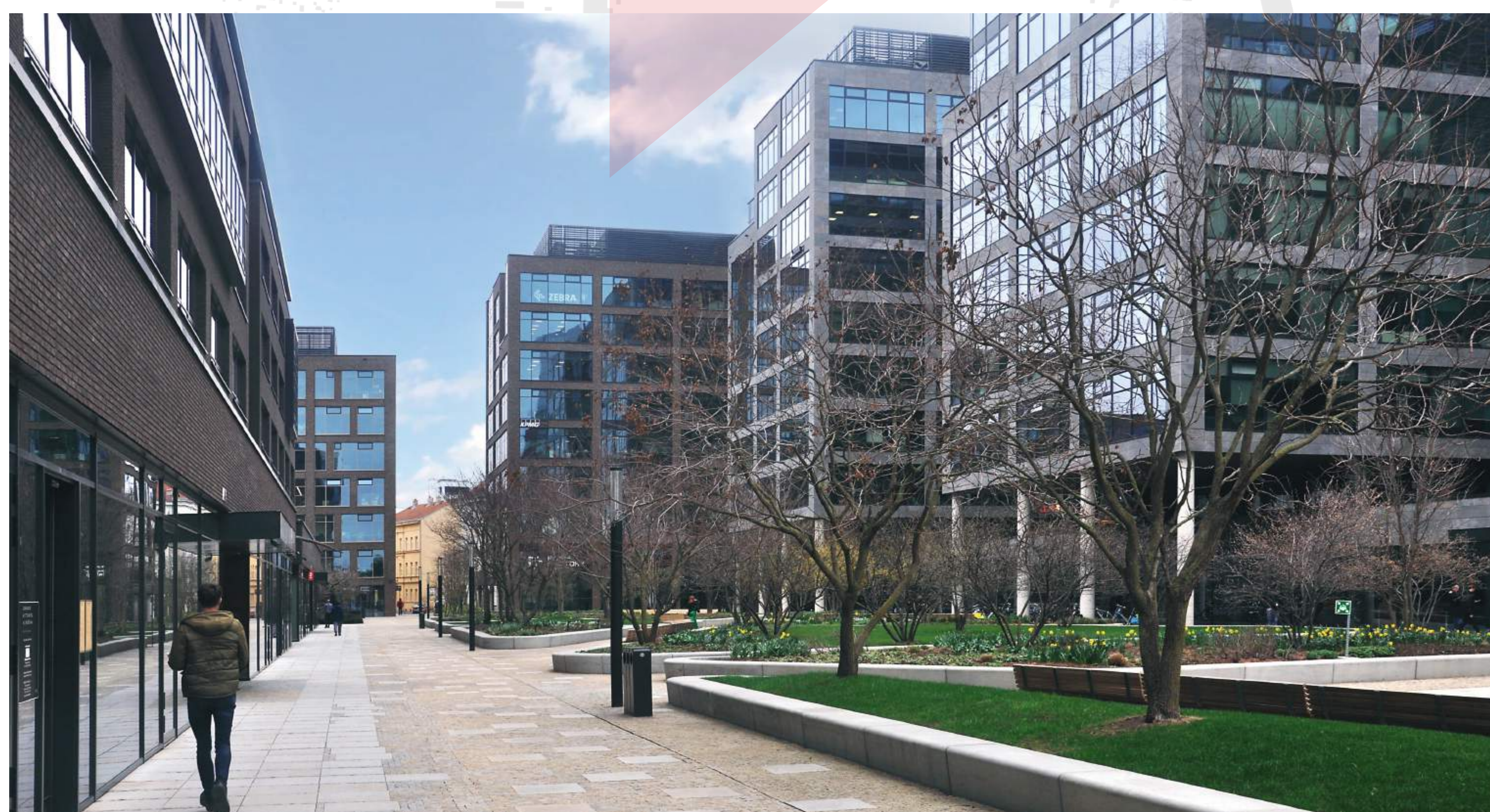
VLNĚNA, REALIZOVANÝ VEŘEJNÝ PROSTOR MEZI BUDOVAMI KOMPLEXU BRNĚNSKÉ KOMUNIKACE
