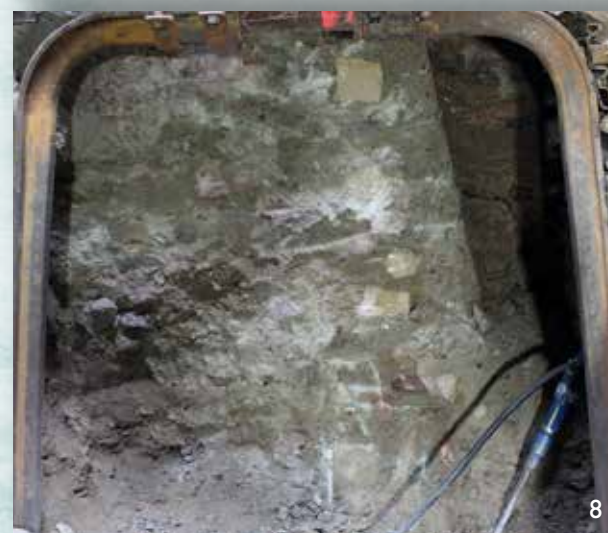
Mostní pilíř a koncové opěrné zdivo Kamenného mostu v ražbách kanalizace na pravém břehu řeky Svratky
