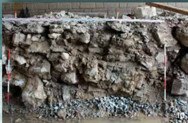
Relikt kamenného pilíře staršieho mostu odkrytý pod dnešným Kamenným mostem při ulici Vídeňská
