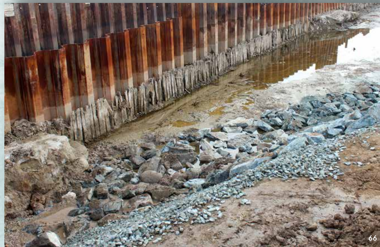
Dřevěné konstrukce zpevňující nově zbudované břehy v prostoru mezi Kamenným a Novosadským mostem, které souvisí s regulací řeky v 1. polovině 20. století.
