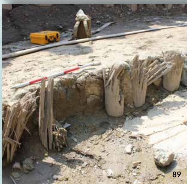
Piloty v korytě řeky u Novosadského mostu, které pravděpodobně souvisí s výstavbou provizorního mostu po druhé světové válce.
