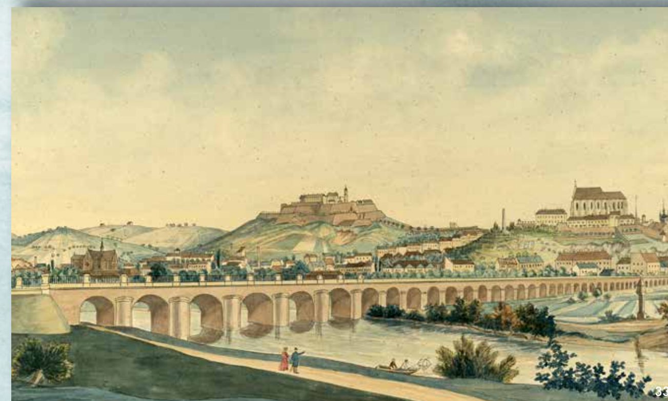
V roce 1839 přijel do Brna první vlak z Vídně. Součástí nové trati byl i viadukt, který překlenul řeku s její širokou zátopovou nivou.
