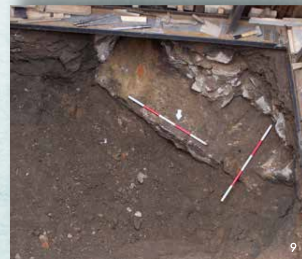
Mostní pilíř a koncové opěrné zdivo Kamenného mostu v ražbách kanalizace na pravém břehu řeky Svratky
