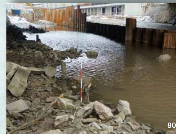
Dřevěné piloty související pravděpodobně s výstavbou Novosadského mostu
