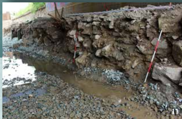
Relikt kamenného pilíře staršieho mostu odkrytý pod dnešným Kamenným mostem při ulici Vídeňská
