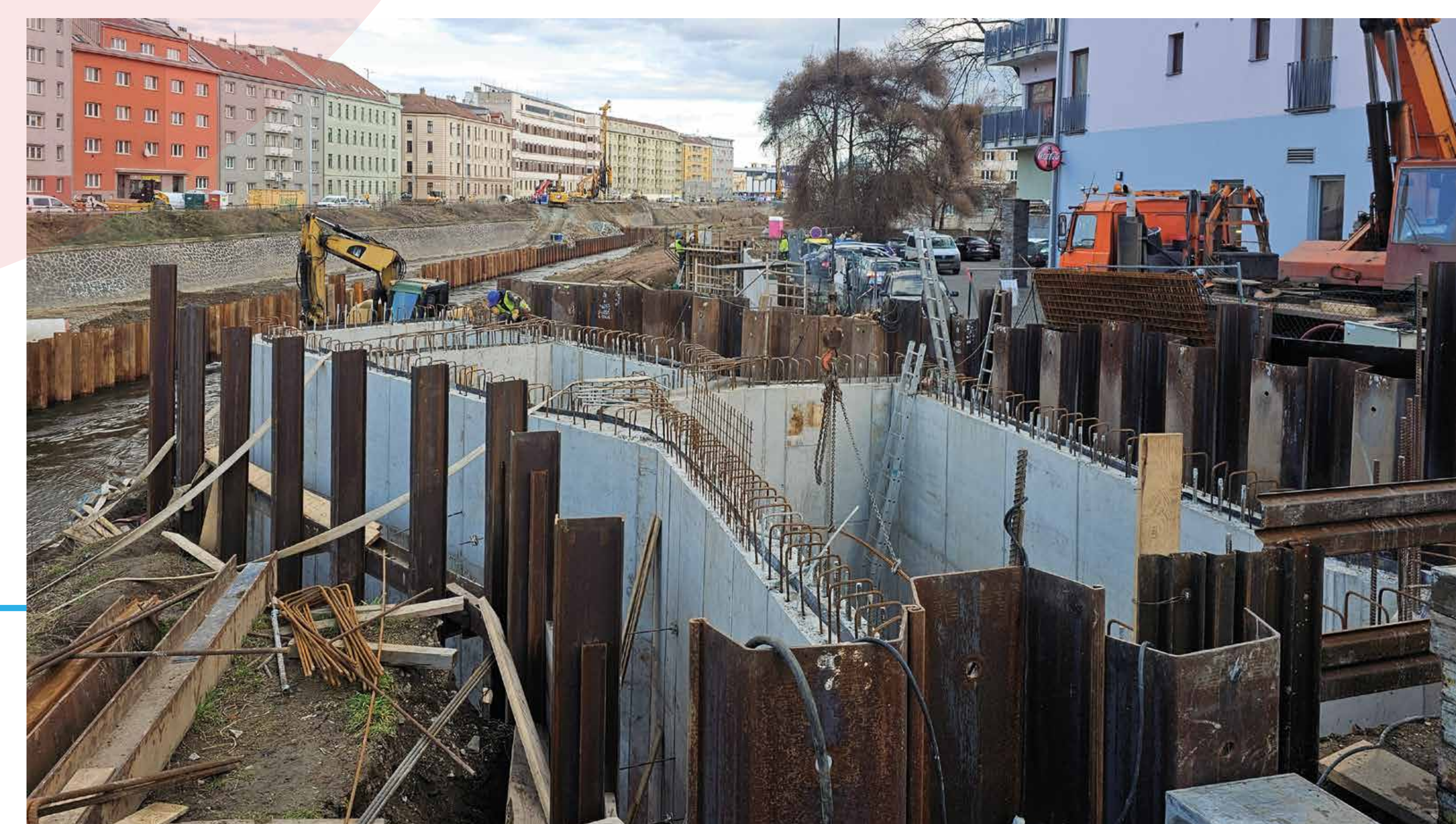
Výstavba nové odlehčovací komory u mostu Vídeňská
