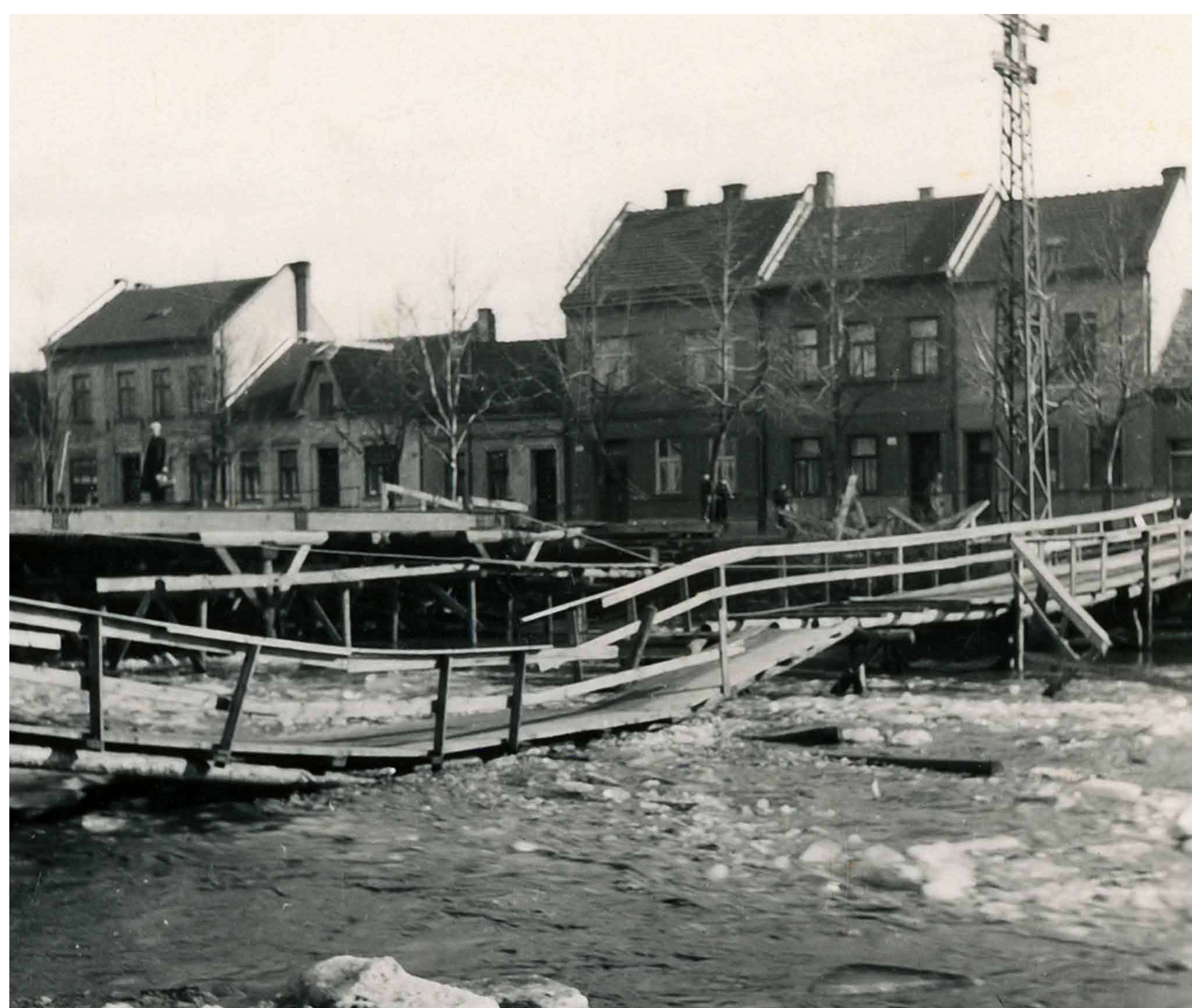
Krami zbořená lávka na Baarově nábřeží, Brno-Husovice, rok 1946
