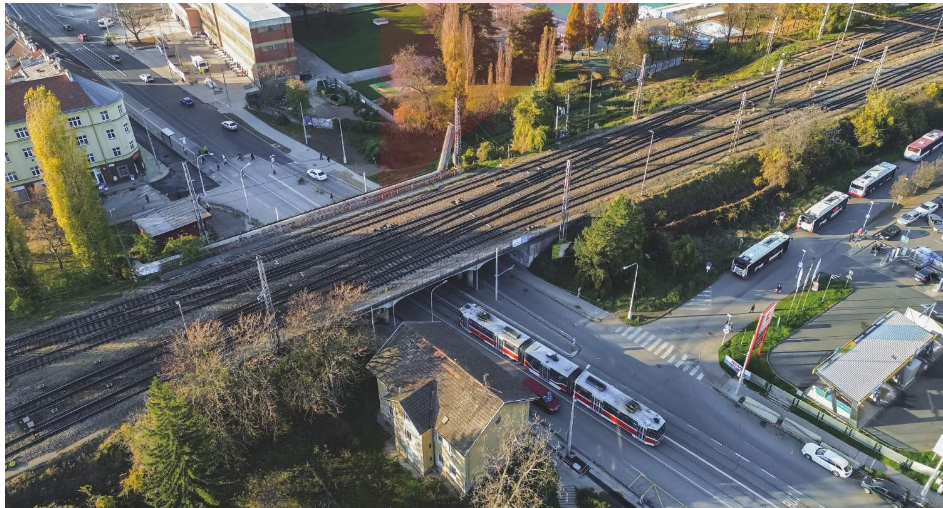
FOTOGRAFIE STÁVAJÍCÍHO MOSTU PŘES ULICI BUBENIČKOVA, V POZADÍ JSOU MĚSTSKÉ LÁZNĚ ZÁBRDOVICE BRNĚSKÉ KOMUNIKACE
