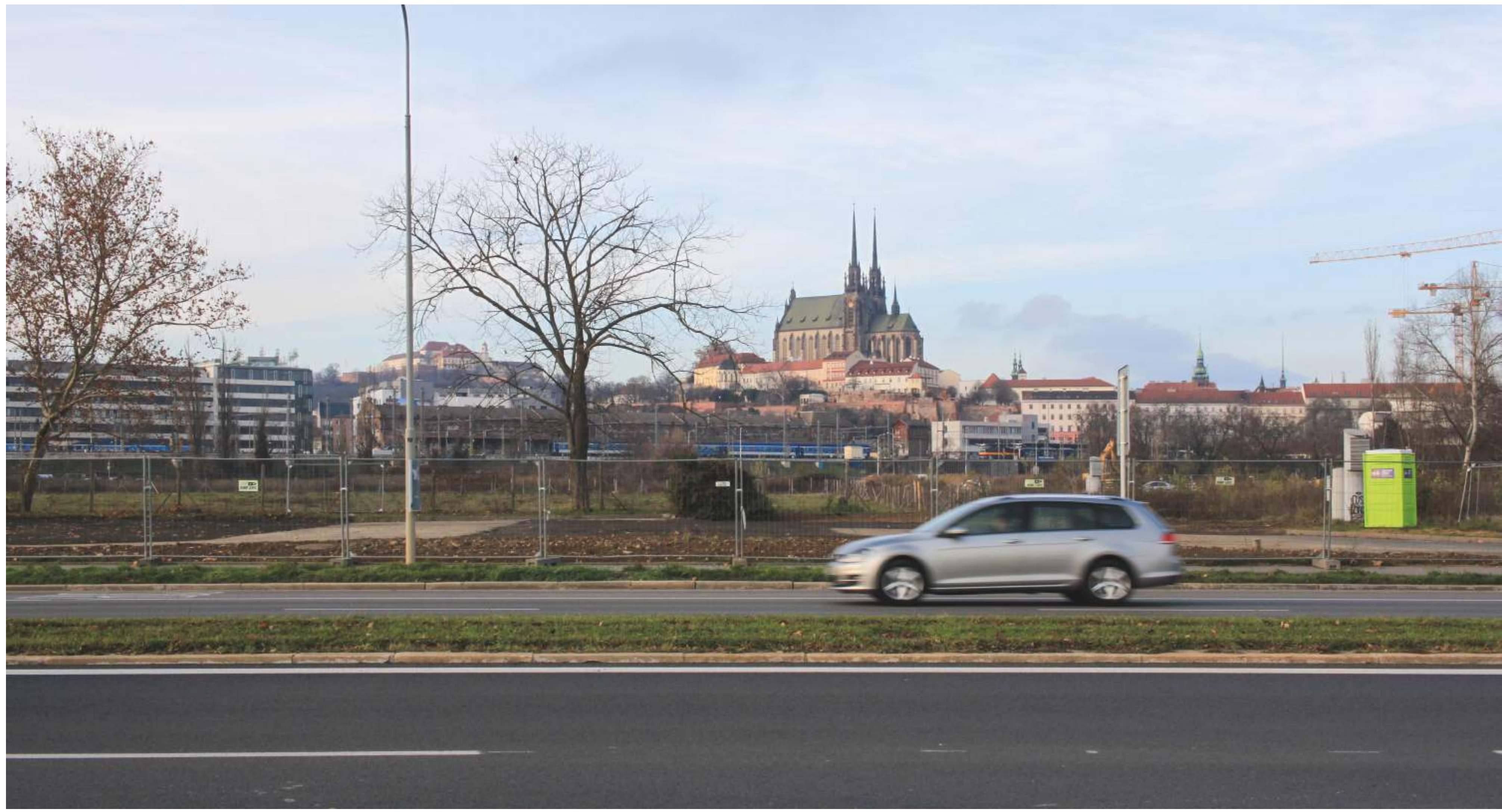
POHLED V OSE BUDOUCÍHO BULVÁRU PO ODSTRANĚNÍ BÝVALÉ ČERPAČÍ STANICE BRNĚNSKÉ KOMUNIKACE
