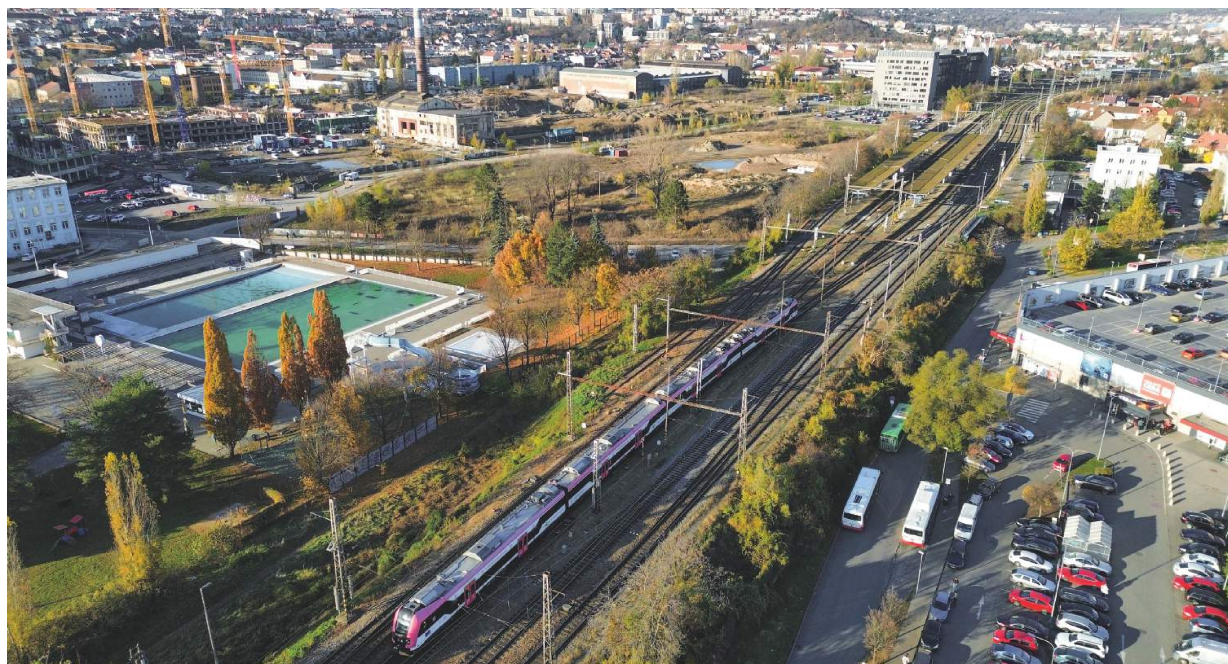
SOUČASNÁ STANICE BRNO-ŽIDENICE BUDE REKONSTRUOVÁNA, V POZADÍ VÝSTAVBA NOVÉ ZBRJOVKY. WEST8
