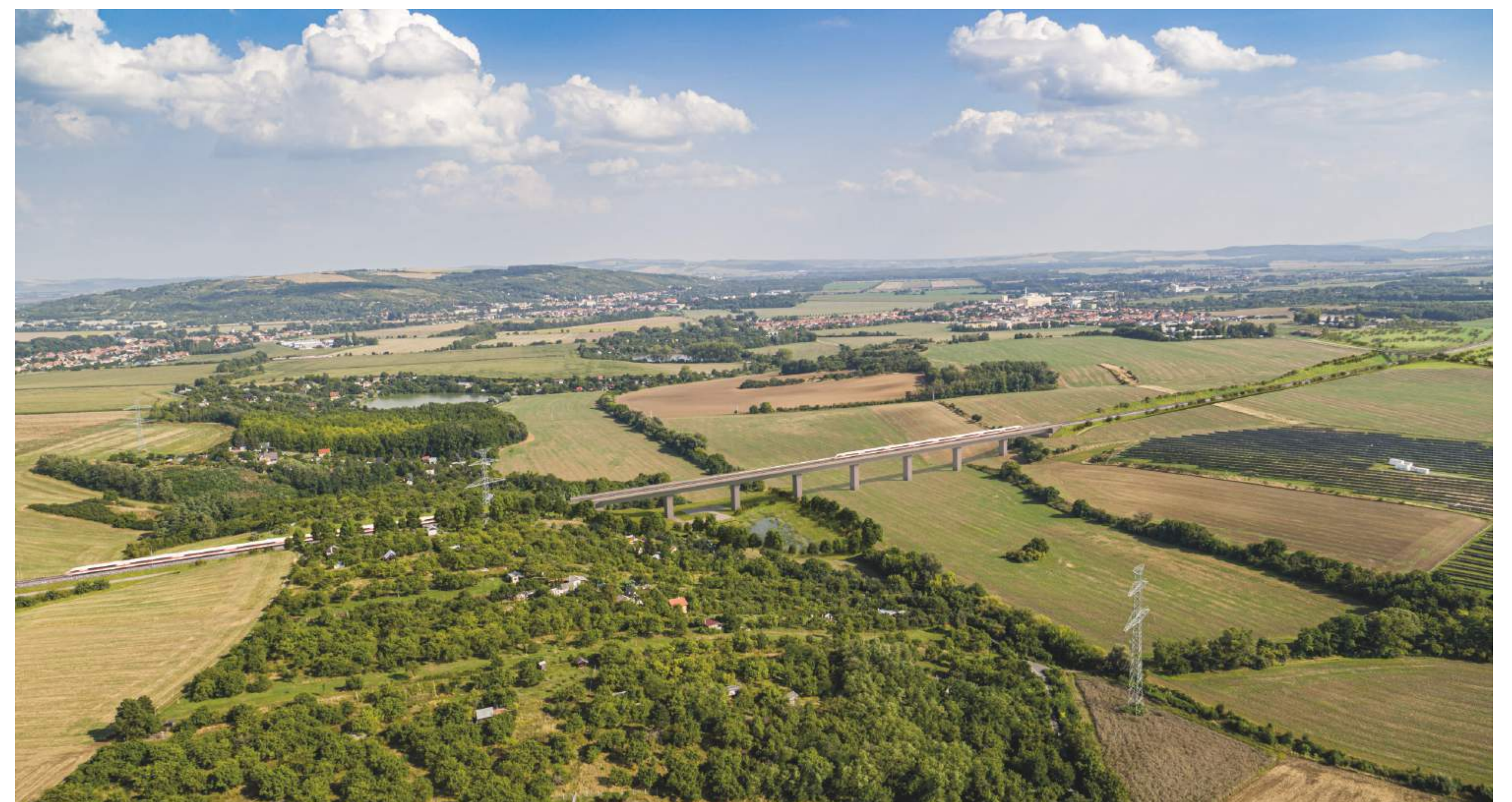
MOST PŘES ÚDOLÍ ŘEKY ŠATAVA, POD ESTAKÁDOU SE NACHÁZÍ RETENČNÍ NÁDRŽ REGULUJÍCÍ PRŮTOK DEŠŤOVÉ VODY Z TRATI SPRÁVA ŽELEZNIC
